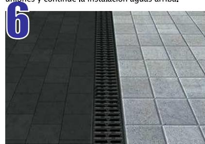
Para un desempeño eficiente, el nivel de la rejilla debe quedar 3 mm por debajo del nivel de piso terminado de las superficies contiguas. Se sugiere implementar acciones periódicas de mantenimiento del sistema.
