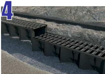
Continúe acoplando los canales hasta la parte superior del sistema, selle las uniones y no se olvide de colocar las tapas de cierre o de salida, según convenga.
