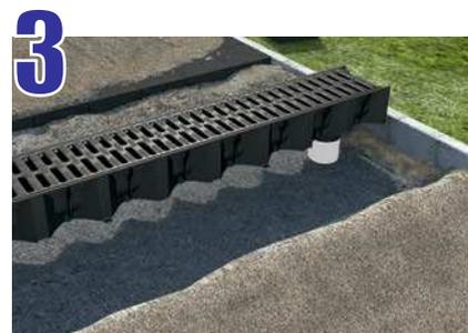
Coloque la descarga donde resulte apropiado, con ayuda del adaptador; selle convenientemente las uniones y continúe la instalación aguas arriba.
