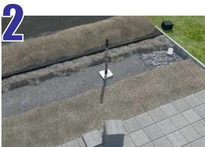
Habilite la descarga del sistema en 4" DWV cédula 40 (si es posible), y coloque una plantilla de concreto de 10 cm para nivelar la superficie de desplante.
