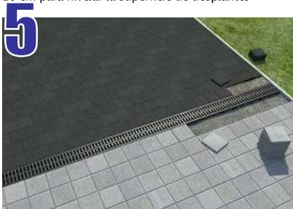
Coloque 10 cm de concreto envolvente a cada lado; considere los niveles, según el proyecto de pavimentos y el acabado de la superficie.
