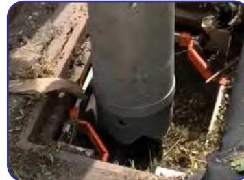
Vacío o aspire la bolsa del filtro si hay demasiado sedimento o residuos.
