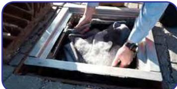
Embone su estructura de Flexstorm® de manera segura.
