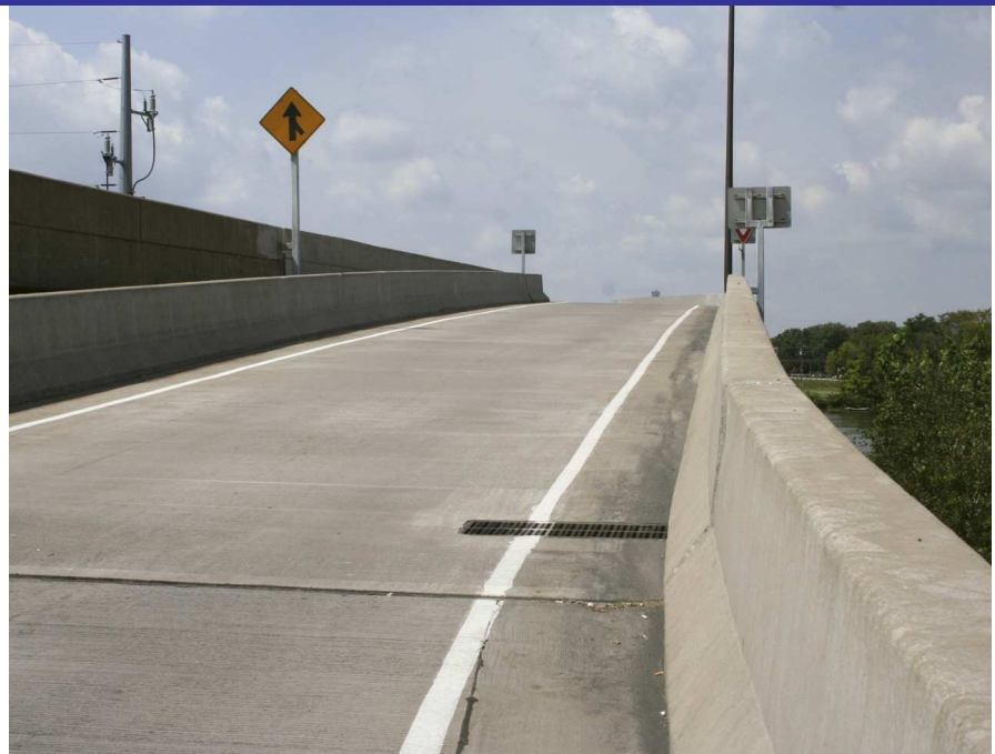
Coladera de fibra de vidrio de 8" ancho interior para interceptar flujos superficiales en puentes
